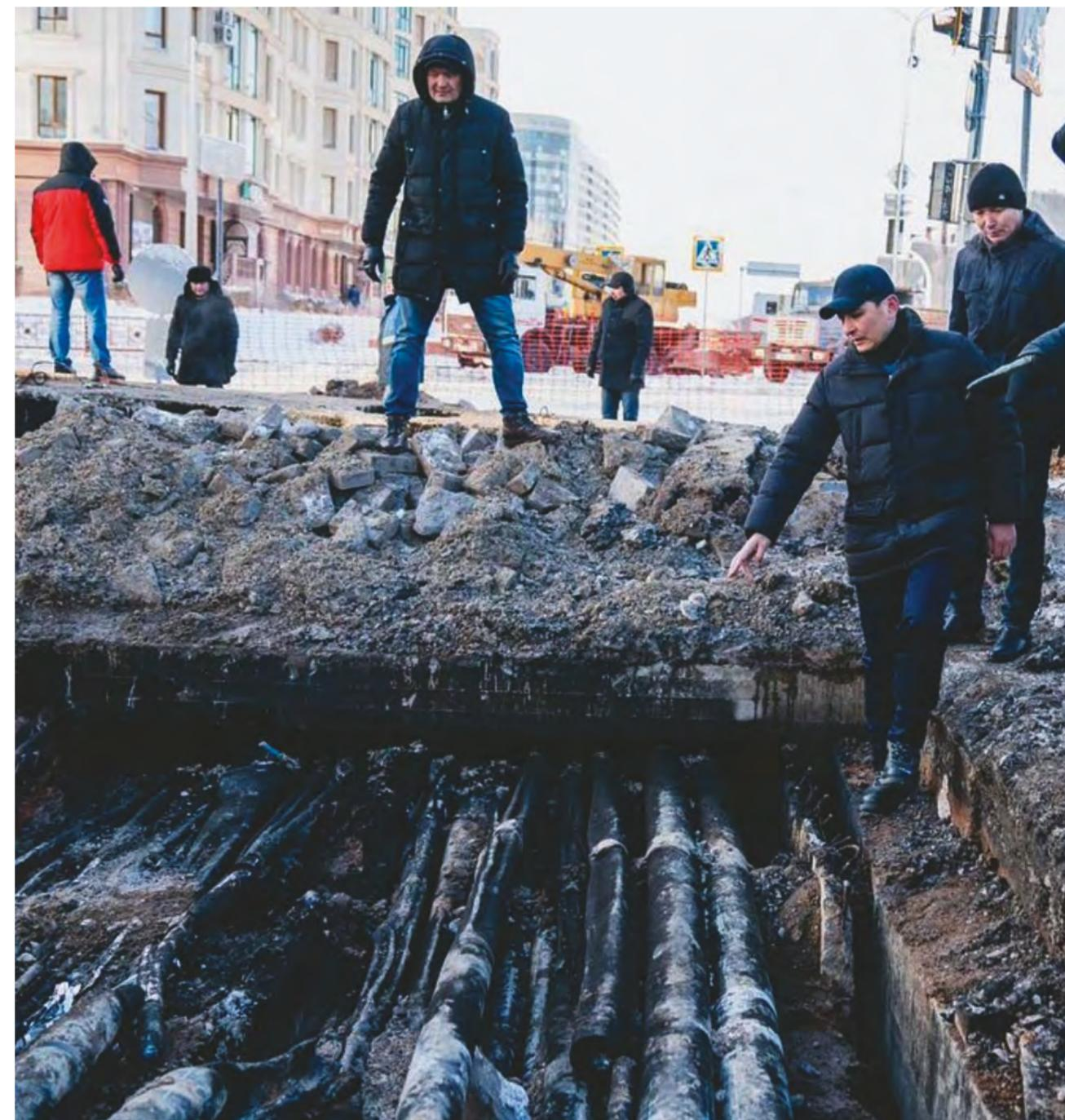
Фото 2. Возгорание трубы в трубном кабельном канале.
