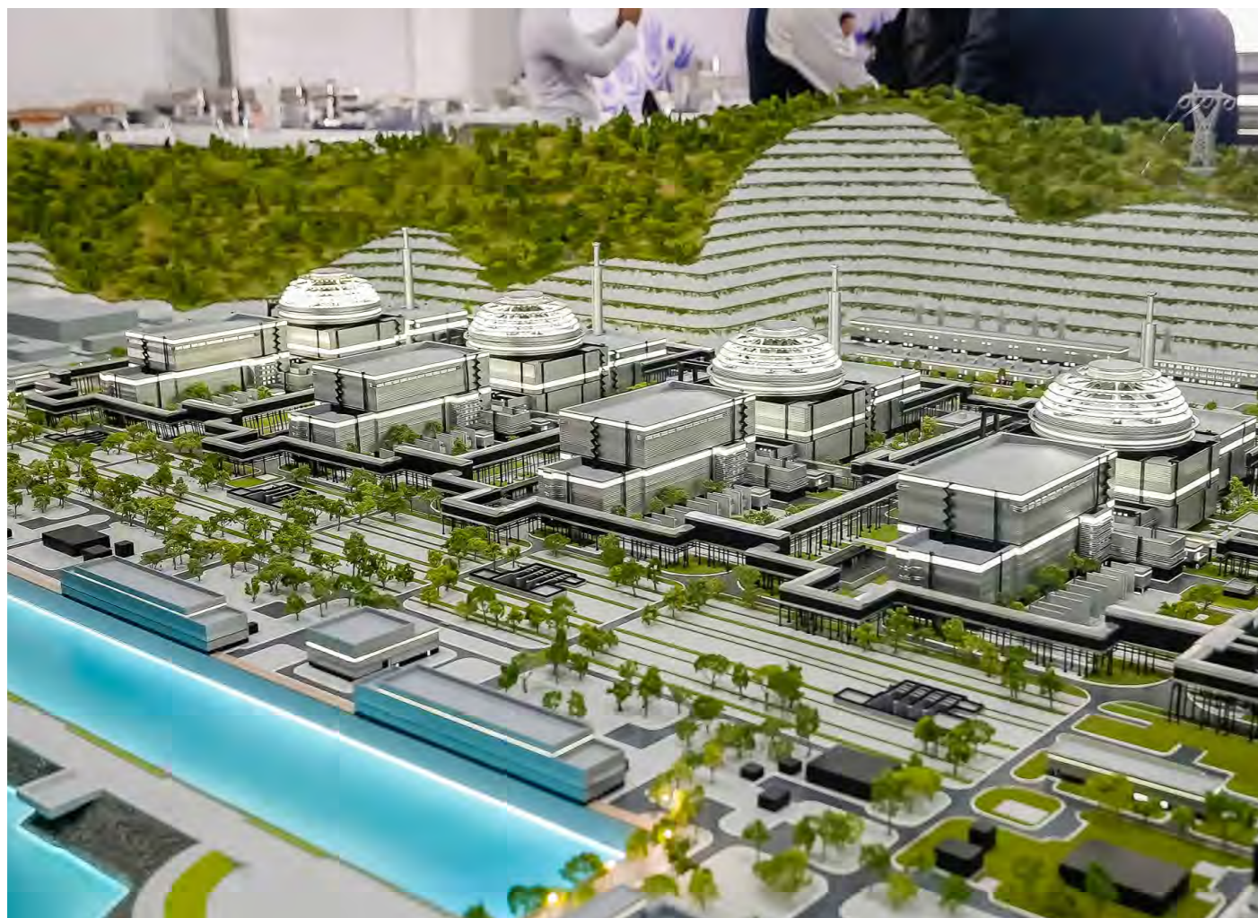
Проект АЭС «Аккую» включает четыре энергоблока с реакторами российского дизайна ВВЭР поколения 3+
