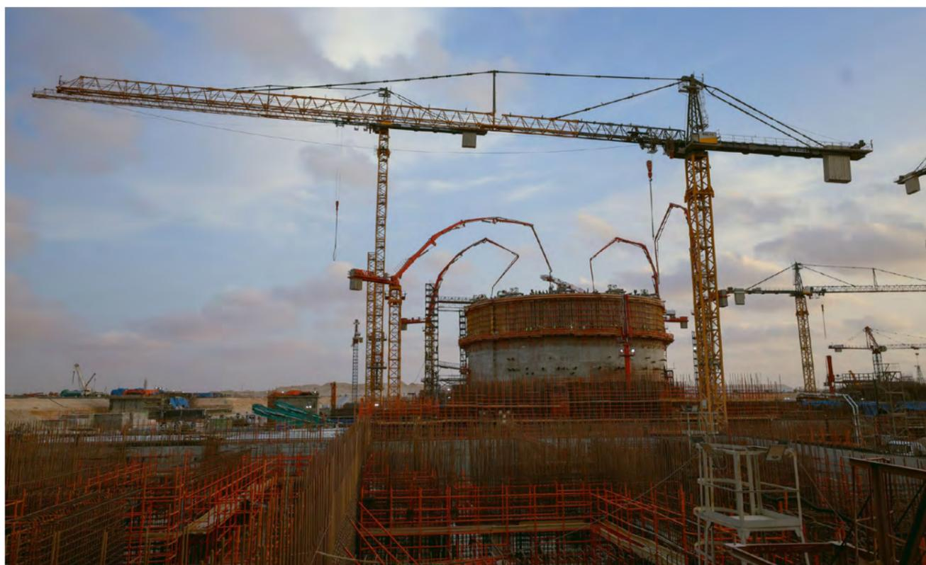
Процесс бетонирования второго яруса ВЗО на втором блоке занял сутки, в работах были задействованы 4 бетонораспределительные стрелы и порядка 65 человек. В здание реактора уложено более 1000 кубометров бетона.
